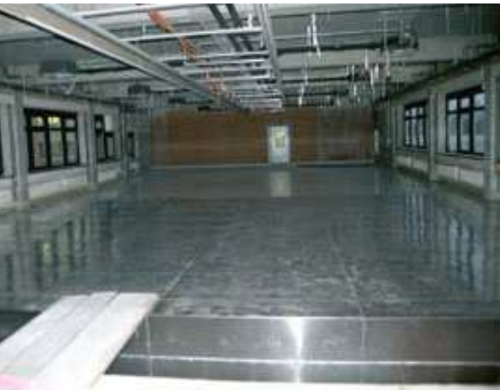
El apantallamiento de amplias superficies dentro de un edificio de oficinas contra una estación de transmisión subyacente con las placas de apantallamiento Aaronia MagnoShield® DUR.
