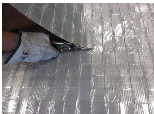
Se corta a medida con tijeras corta chapa
